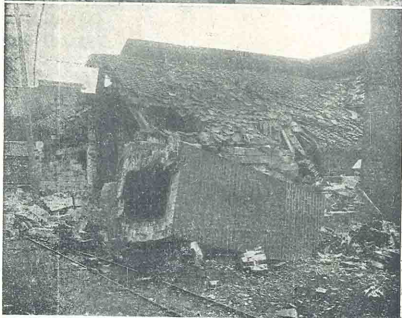
炊場の煙突倒壊して炊場を破壊す
