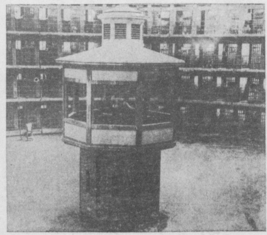
上圖はいはゆる「南部青牢」と稱するもので總栗材の堅牢なものを青銅色に塗った鐵の延金を打ちつけた舊藩時代の牢屋、之れは大正二年に盛岡に幼年監建築につき解崩した。下圖は突飛な試みをする米國イリノイス州立刑務所で電氣化掛で一せいに扉が開き中央の塔で見張りをすると云新しいもの。
